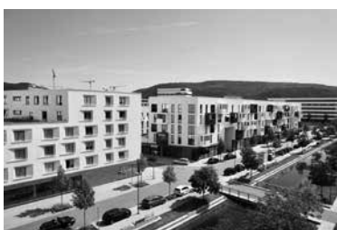
Heidelberg – pasívne bytové domy
