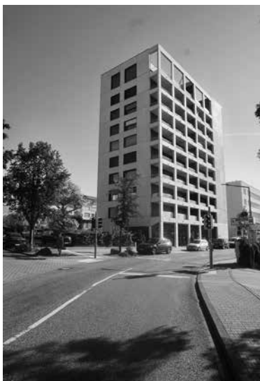
Pforzheim – obnova obytnej budovy
