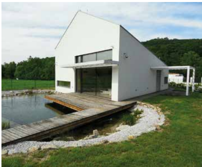
Udržitelný dom, Borinka, 2013
