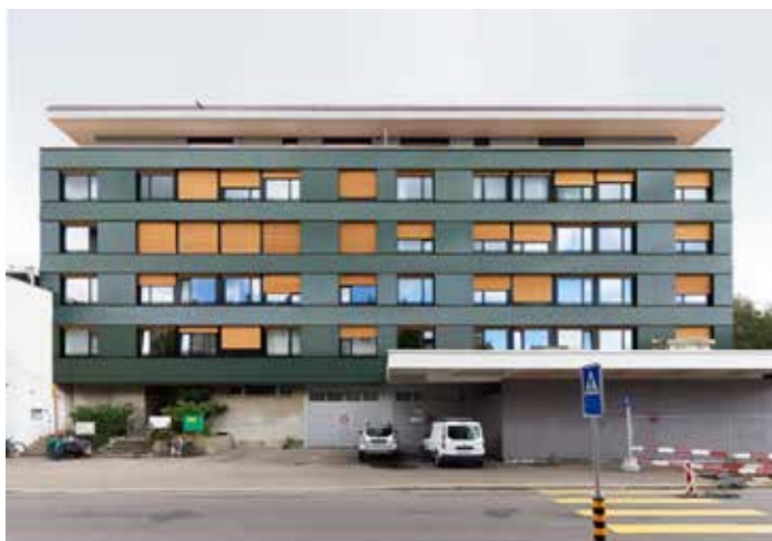
Obrázok 43 Fotovoltická fasáda, Obnova, Salathe architekten, Bazilej Figure 43 Photovoltaic facade: Redevelopment, Salathe architekten, Basel
