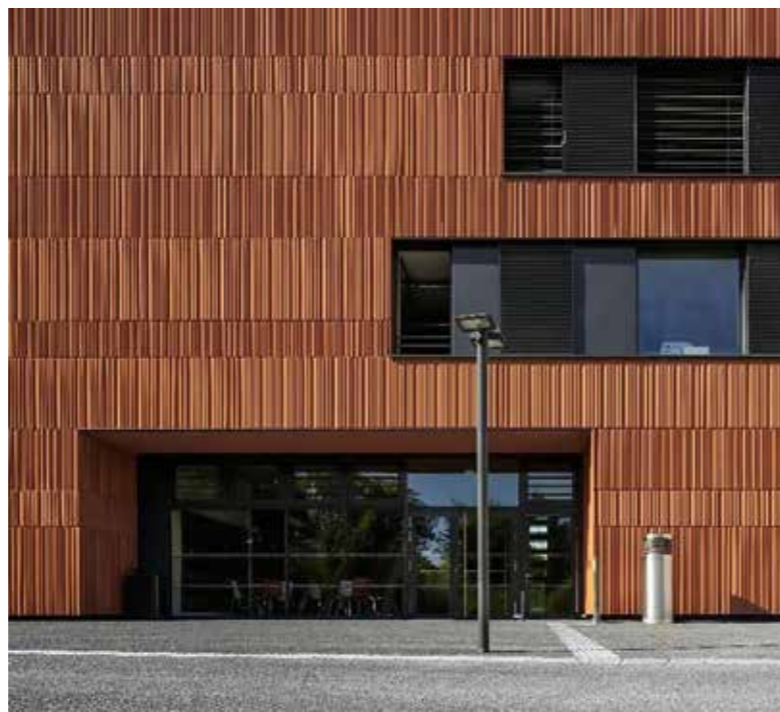
Obrázok 38 a Obrázok 39 Ochrana proti dažďu a vlámaniu, prednášková a administratívna budova, HS Landshut, POS architektken Figure 38 and Figure 39 Rain and burglary protection, Hörsaal und Verwaltungsgebäude, HS Landshut, POS architecten
