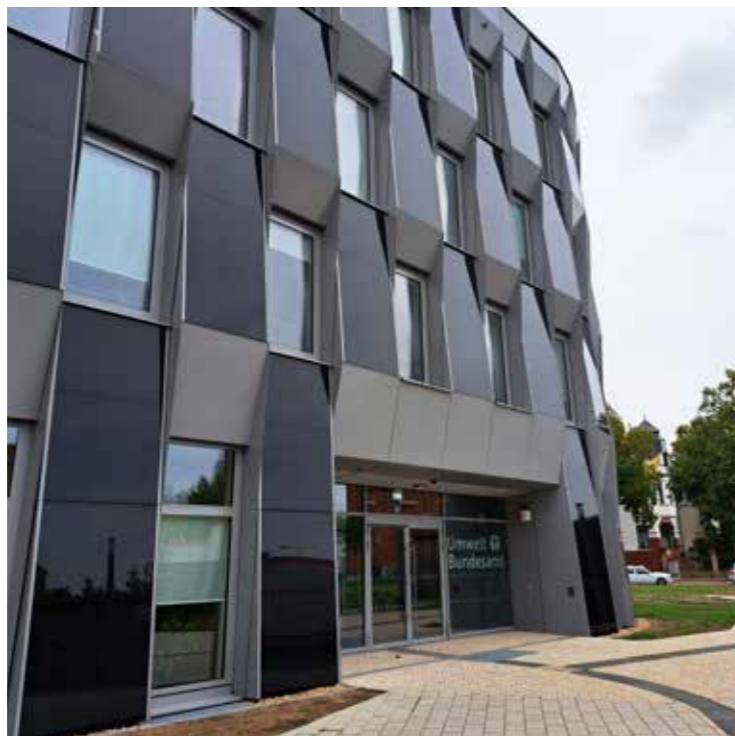
Obrázok 56 Fotovoltika na fasáde, Nemecká spolková agentúra pre životné prostredie v Dessau, autorka: Ivana Nemethová Figure 56 Photovoltaics on the facade, German Environment Agency in Dessau, Photo by Ivana Nemethová
